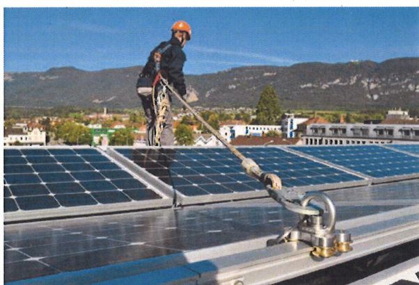
Fig. 9 Système de retenue
