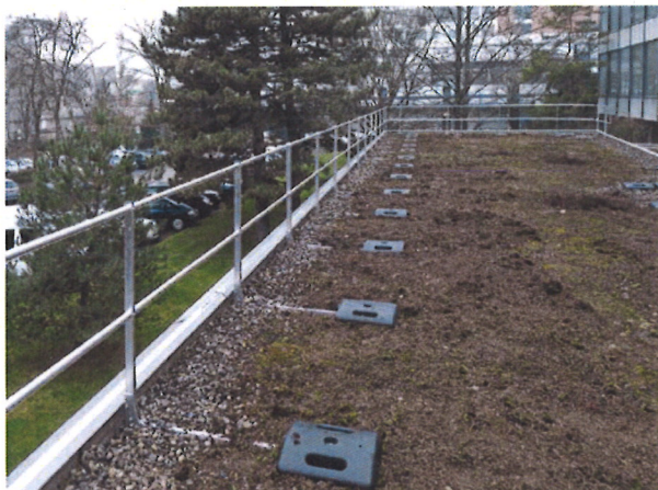
Fig. 1 Une protection collective offre une sécurité optimale au bord du toit.
